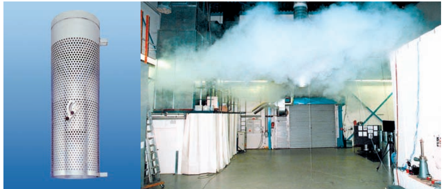
Abb.4 Verdrängungsauslass in 3 m Höhe
