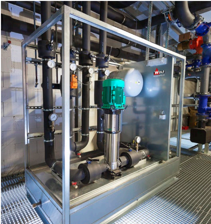
Abb. 1: Das Hochleistungs-Kreislaufverbundsystem ist die ideale WRG im Hygienebereich.
