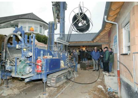
Abb.9 Bei einer „Erdsondenparty“ können Interessenten die Bohrung live miterleben
