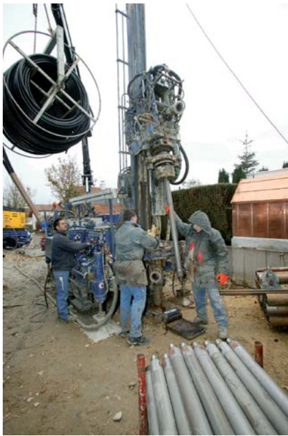
Abb.4-6 Bohrung und Installation einer Erdsonde
