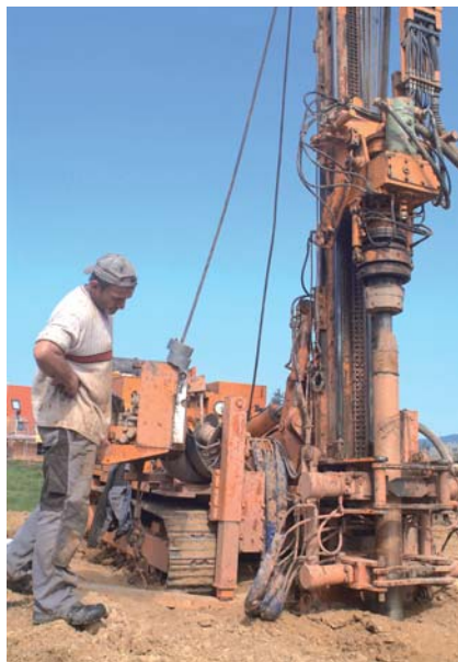
Abb.8 Erdbohrung für die Erschließung der Wärmequelle
