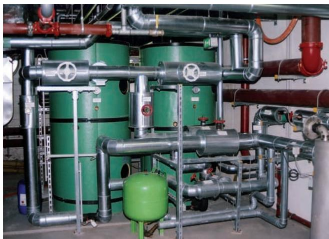
Abb.2 Zwei 1.000l Speicher, redundant angeordnet, versorgen den SPA-Bereich zu jeder Zeit mit ausreichender Menge erwärmten Trinkwassers.
