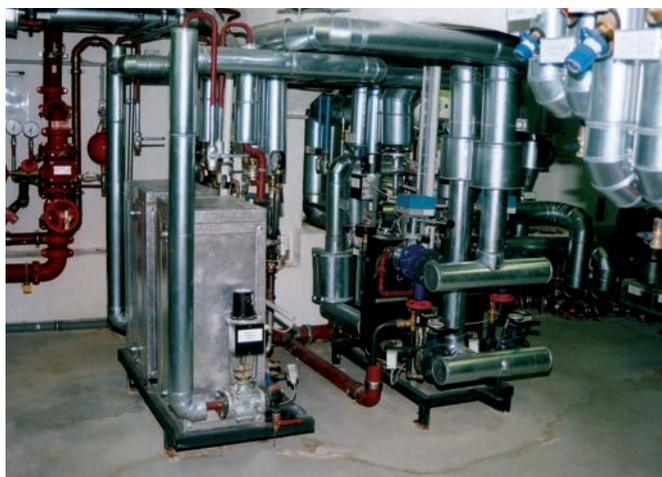
Abb.1 Die Heizzentrale des Hauptgebäudes ist mit ihren beiden geschraubten Plattenwärmeübertragern redundant ausgeführt.
