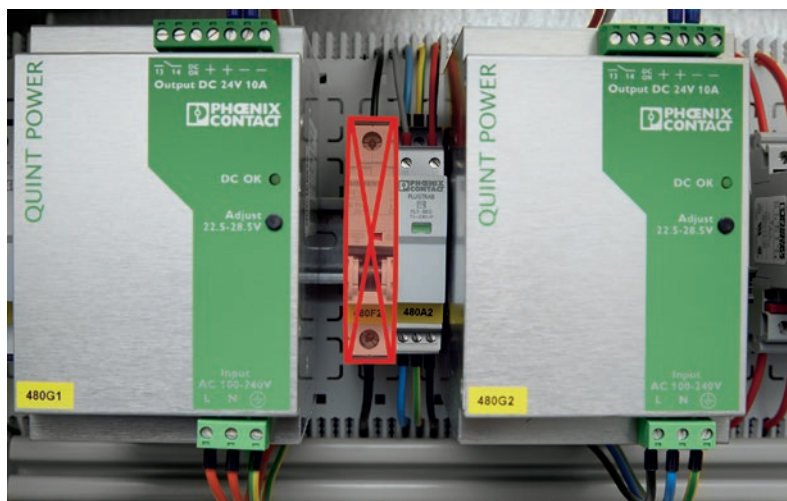
Abb. 3: Sicherungen bereits integriert – mit dem neuen Geräteschutz Typ 3 (Bildmitte) kann auf einen separaten Überspannungsschutz (rot) für den Ableiter verzichtet werden.
