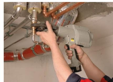
Abb. 6: Bei der Inliner-Installation mit dem System „Smartloop“ wird in den Steigestrang aus Kupfer oder Edelstahl ein flexibles Inliner aus Polybutenrohr von der Rolle eingezogen.
