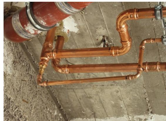
Abb. 4: Blick auf eine im Rahmen einer Sanierungsmaßnahme erstellte Inliner-Installation mit Kupferrohr. Deutlich erkennbar ist der Platzgewinn, weil auf den zweiten Steigestrang verzichtet werden konnte.
