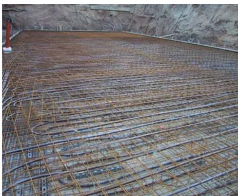
*Rohrlage an der Bewehrung in der Bodenplatte befestigt*
