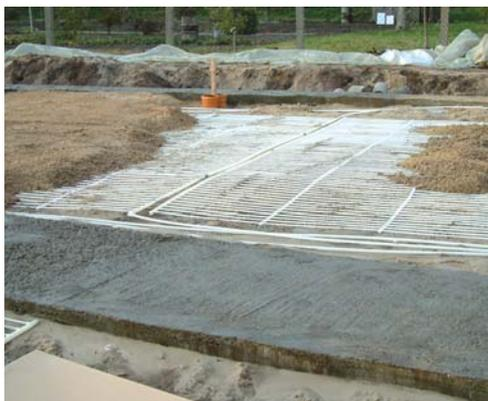
*Rohrlage in der Sauberkeitsschicht unter der Bodenplatte*
