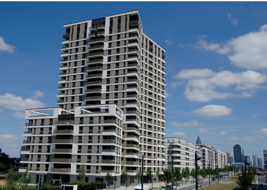
Das 66-Meter hohe Hochhaus Westside Tower bildet das Eingangsportale zum Neubaugebiet „Europaviertel“ in Frankfurt am Main.
