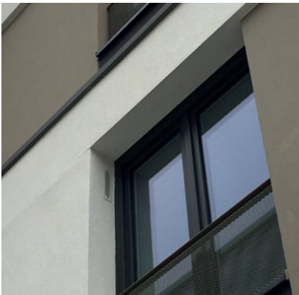
Wand-Außenluftdurchlässe sorgen dank Feuchteführung und hoher Schalldämmung für einen verbesserten Wohnkomfort der Nutzungseinheit.
