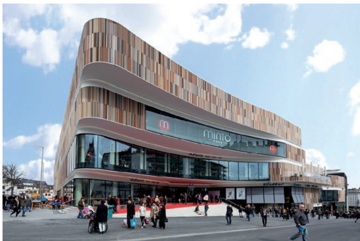
Abb.1: Das Minto in Mönchengladbach mit wellenförmiger Außenfassade aus Keramiklamellen (Foto: mfi Shopping Center Management)
