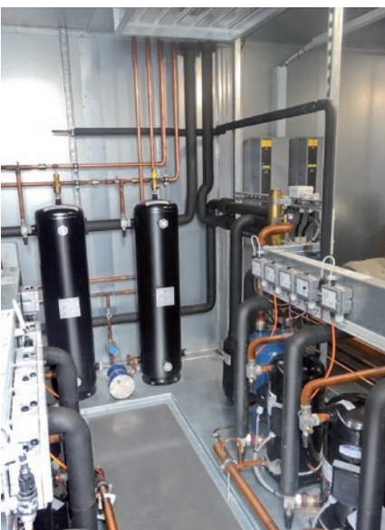
Abb.4: Bis zu 8 Scroll-Verdichter mit stufenloser Leistungsregelung von 5 - 100%
