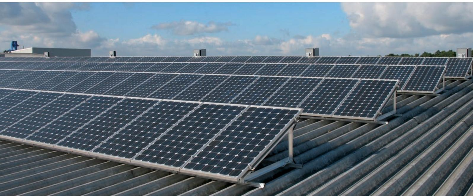
Abb.1 Aufgeständerte Flachdachanlage
