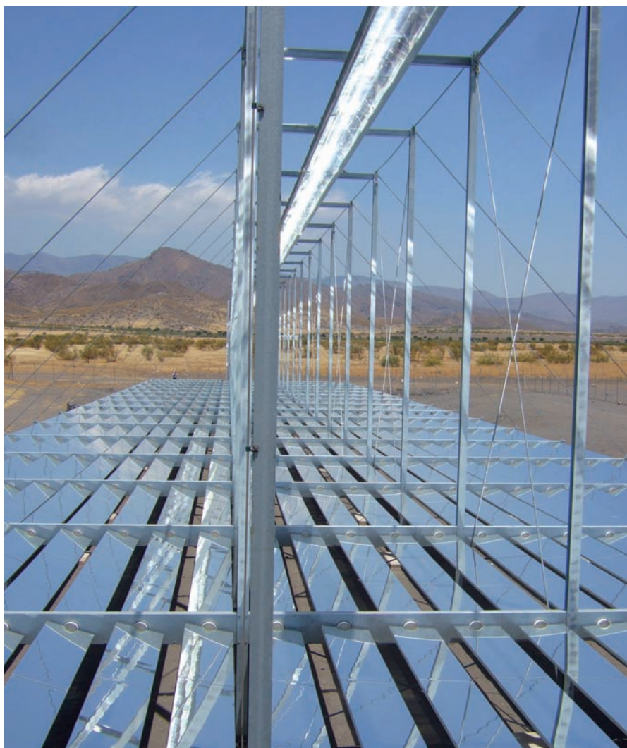
Abb.10 Solarthermische Versuchsanlage in Almeria, Spanien (aus Vortrag „The big picture – PV in the next 20 years“) Foto: Fraunhofer ISE
