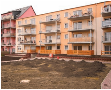
Abb.2 Mehrfamilienhaus mit 40 Wohneinheiten in Cottbus. Heizung und Warmwasserbereitung übernehmen zwei Wärmepumpen von Dimplex.
