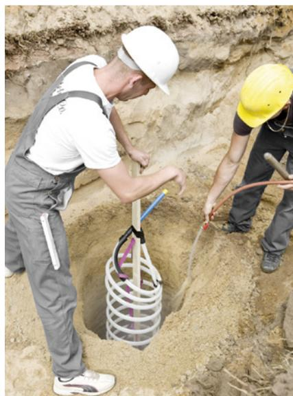
Abb.10: Schneller und einfacher Einbau einer Helix-Sonde aus PE-Xa
