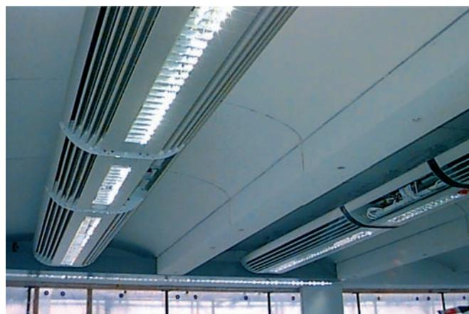
Abb.2 Ein passiver Kühlbalken als Multifunktions-Konvektor mit integrierter Kühlung, Beleuchtung und Kabelkanälen für Lloyds in London.
