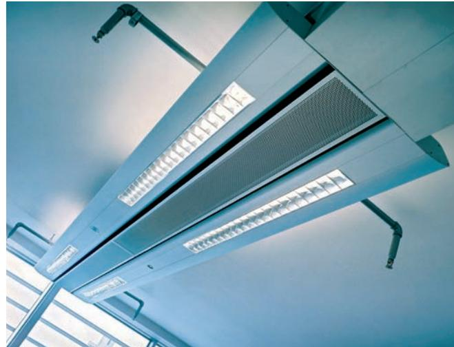
Abb.9 Endgültige Multifunktions-Kühlbalken fertig installiert unter der Decke eines typischen Büroraumes
