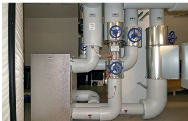
Zum Schutz vor Verunreinigungen entschied sich das Installationsunternehmen zu einer Systemtrennung zwischen dem alten Heizungsnetz und der neu aufgebauten Heizzentrale.
