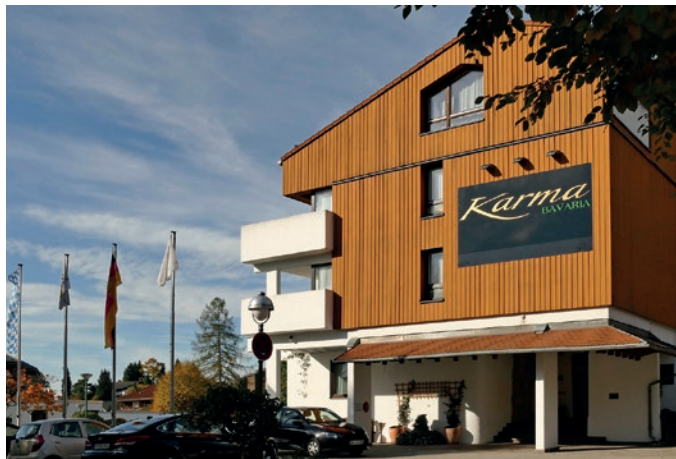
Das ehemalige Hotel Alpenclub in Schliersee heißt seit 2015 Karma Bavaria. Energetisch ist die Bausubstanz auf dem Stand der 1970er Jahre, doch eine nachträgliche Wärmedämmung erwies sich als unwirtschaftlich. Stattdessen entschied sich der Eigentümer für eine energetische Modernisierung der Heizzentrale mit BHKW und zwei Gas-Brennwertheizkesseln.
