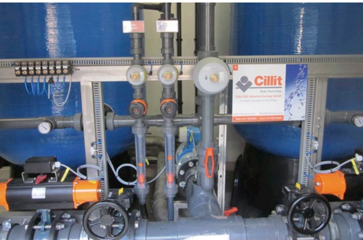
Abb.4: Enthärtungsanlage
