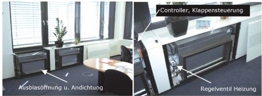
Abb.10 u. 11 Einbausituation der PCM-Geräte in einem Süd-West-Büro im Imtech-Haus
