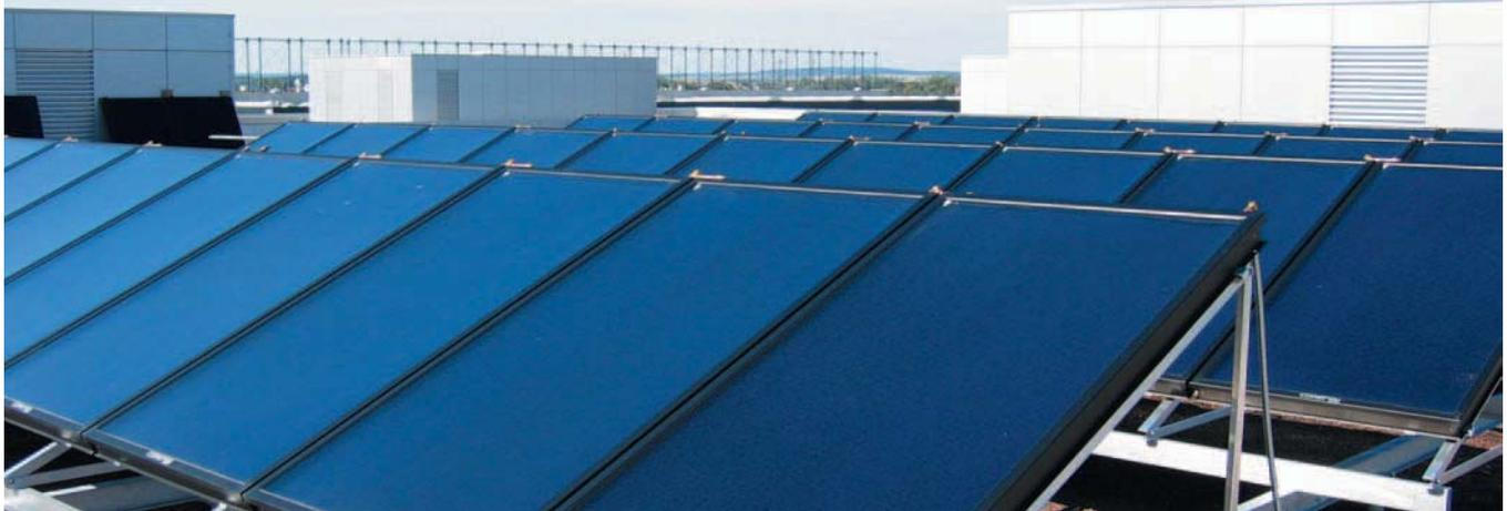
Abb. 1 Kollektorfeld für solare Kühlung mit optimierten Kollektoren (Conergy F 6000)
