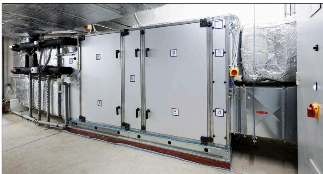
*Abb.1: Kompakt: die zentrale Lüftungsanlage Typ „DV 30“ überzeugte in der Planung sowohl durch die Baumaße wie durch die hohe Energieeffizienz, zu der auch bis zu 85% Wirkungsgrad bei der Wärmerückgewinnung gehören.*
