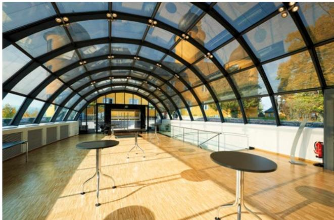
Abb.2: In der Glaskuppel mit ihren verschattenden Photovoltaikmodulen steigt selbst im Sommer die gemessene Temperatur dank der umlaufenden Lüftung in der Balustrade nicht über 24 °C.
