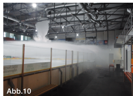
Abb. 5-10 v.l.: Die Temperaturen auf dem Eis liegen bei optimalen Kältetemperaturen, während die Zuschauer auf den Rängen keineswegs frieren müssen. Die Kaltluftschicht auf dem Eis (Abb. 10) bleibt bei dieser Konzeption ungestört.
