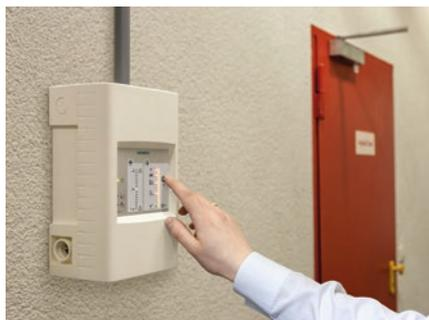
Abb.4: Der neue Ansaugrauchmelder von Siemens hilft dabei, Brände frühzeitig zu erkennen.
