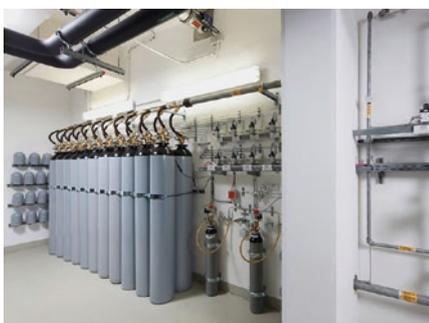
Abb.5: Bereit für den Einsatz: Behälter für die Löschanlage eines Data Centers
