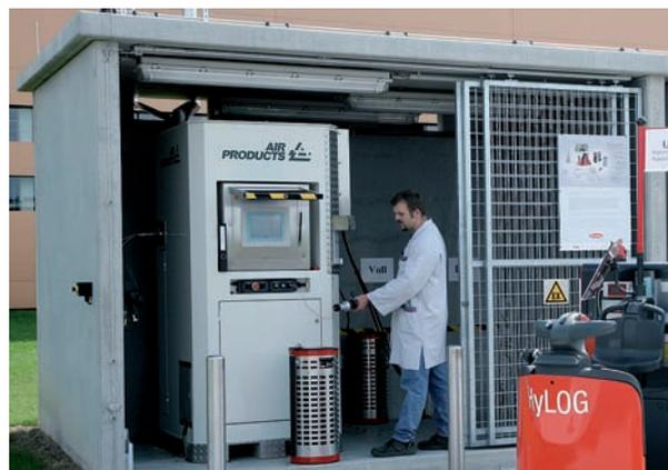
Abb.3: An der Wasserstofftankstelle wird die Kartusche mit Wasserstoff befüllt. Der Vorgang dauert weniger als 5 Minuten und funktioniert genauso einfach wie bei einer Fahrzeugbetankung mit Erdgas
