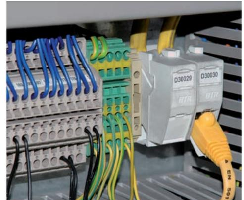
Informationstechnischer Anschluss im Steuerschrank
