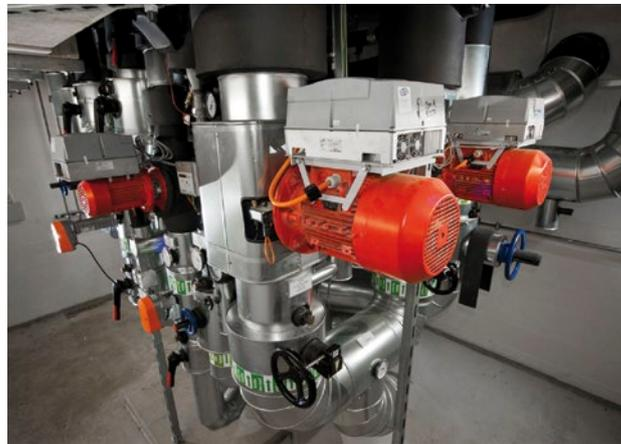
Abb.1: Wo große Fördermengen und hohe Drücke erforderlich sind, gleichzeitig sich aber laufend die Entnahme oder Umwälzmenge verändert, passt die von KSB entwickelte Pumpendrehzahlregelung PumpDrive die Förderleistungen dem jeweils momentanen Bedarf an.
