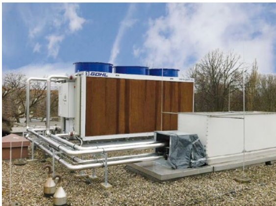
Abb.1: Trockenkühler Topaz T3, Schön Klinik, in Hamburg
