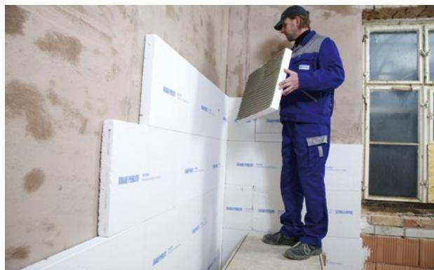
Abb.5: Moderne, kapillar aktive Innendämmsysteme für Außenwände sind in der Lage, die Luftfeuchtigkeit zu puffern und somit das Raumklima zu regulieren.
