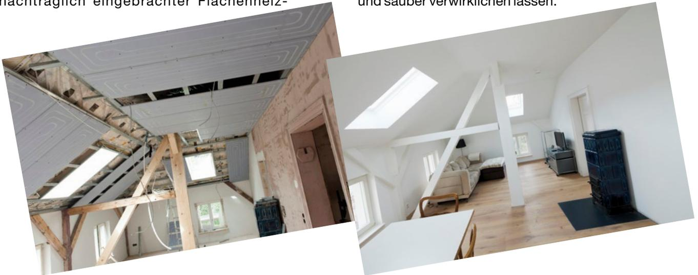
Abb.1: Trockenbau-Lösung für Wand und Decke: Das Renovis Trockenbauelement kann mithilfe einer handelsüblichen Unterkonstruktion aus CD-Profilen schnell und sauber montiert werden.
