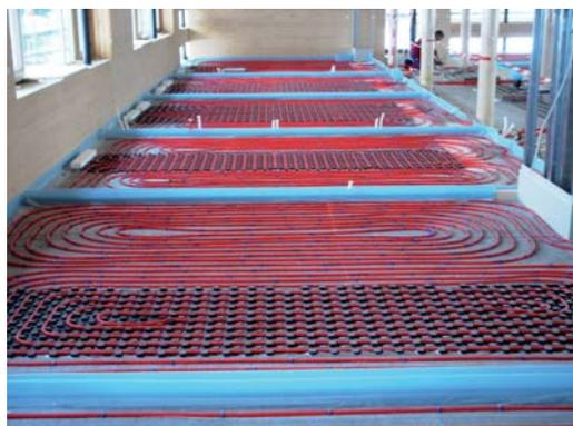
Abb.1 Multifunktionales Flächenheiz- und Lüftungssystem
