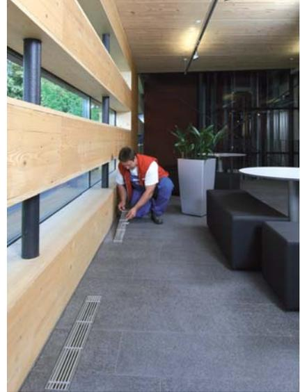
Abb.3 Dezentale Luft-Auslässe sorgen für geregelte Be- und Entlüftung
