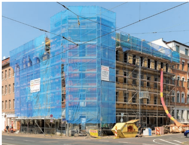
Abb. 1+2: Bei einem Mehrfamilienhaus in Leipzig wird die Sanierung des Bestandsgebäudes mit Luft/Wasser-Wärmepumpen und dezentraler Warmwasserbereitung in jeder Wohnung klimatechnisch perfektioniert. Eine komplette Nachdämmung der Fassade und des Dachstuhls trägt weiterhin zu einem niedrigeren Wärmebedarf bei – ein ideales Argument für die Mietverträge!
