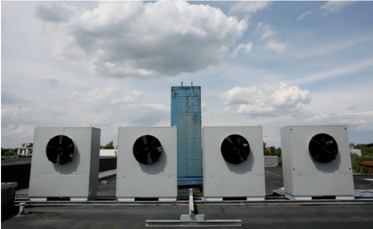
Abb.4: Eine platzsparende Möglichkeit der Aufstellung von Luft/Wasser-Wärmepumpen ist auf dem Dach. Die Geräte werden dabei mit dem Kran aufs Dach gehoben und auf Stahlträgern befestigt.
