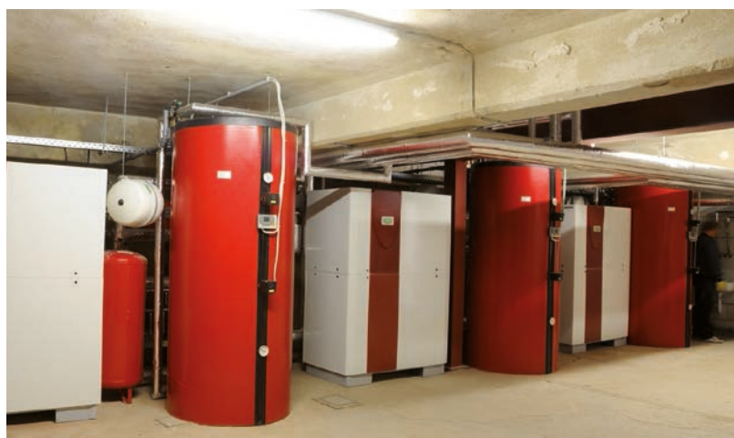
Abb.5: Als weitere Variante gilt eine Sole/Wasser Wärmepumpe (hier Glen Dimplex Typ SI 50TE) in Reihenschaltung
