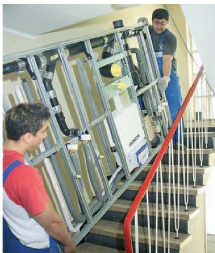
Abb. 1 Vorgefertigte Elemente aus der Werkstatt
