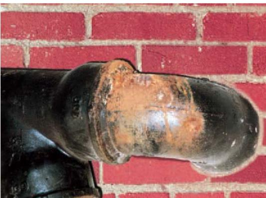
Abb. 4 Korrosion an Gußrohren durch Fettablagerungen innen (SML-Rohr)
