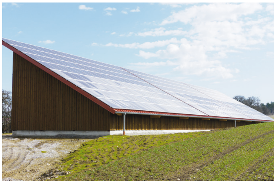
Abb.4: Bachmann-Anlage - größte Anlage mit Albarino-G-Glas
