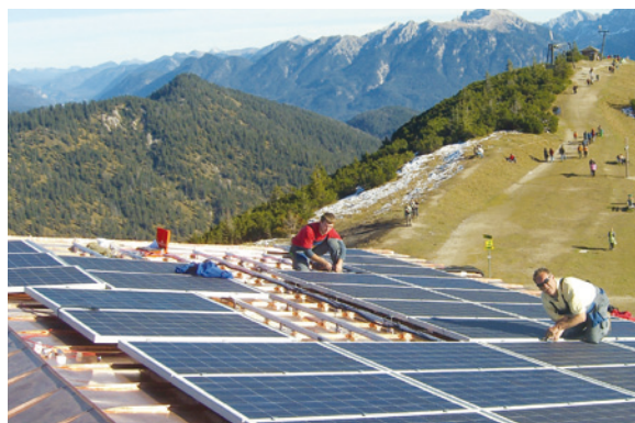
Abb.2: Montage einer Emmvee-Anlage in den Voralpen
