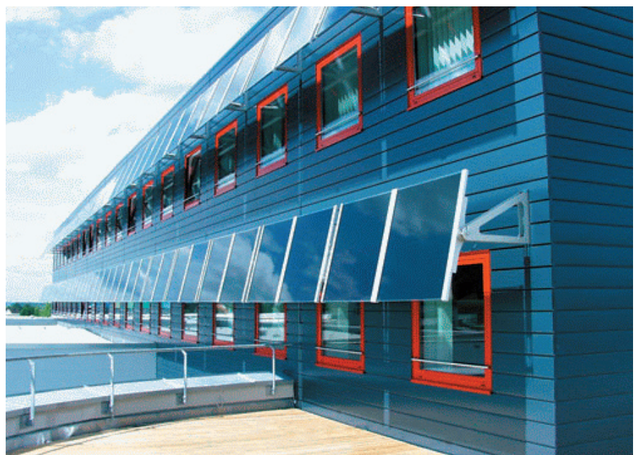
Abb.3: Bewegliche schwebende Solarmodule zum Sonnenschutz
