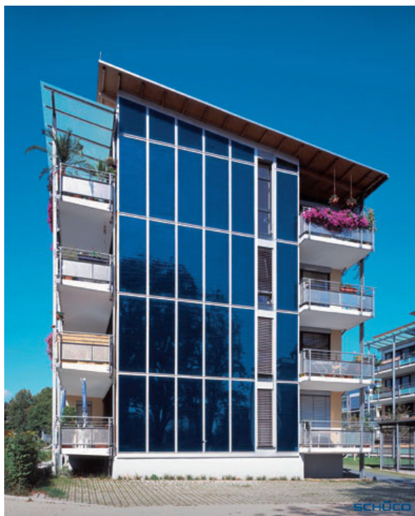
Abb.4: Schwenkbar montierte Solarmodule
