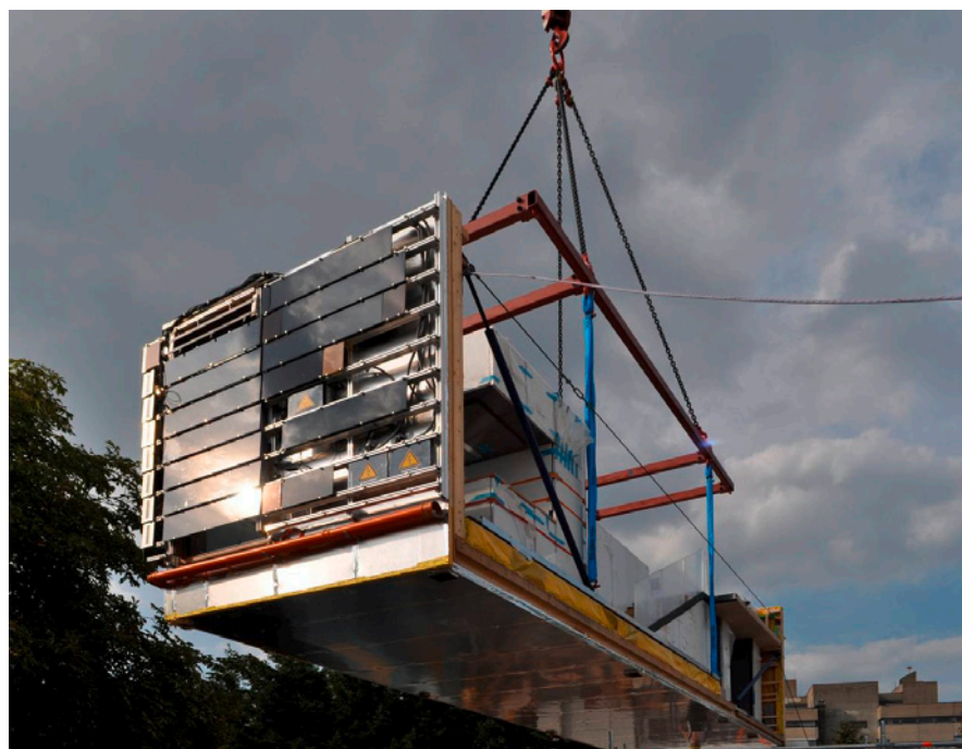
Abb. 6: Gebäude bei der Transportvorbereitung
