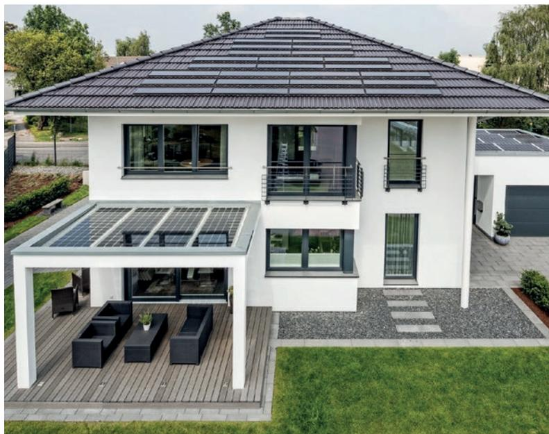
Abb. 1: Nelskamp-Energiedach erzeugt Strom und Wärme
