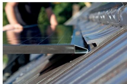
Abb. 9: Einstecken des Moduls in obere Nut
