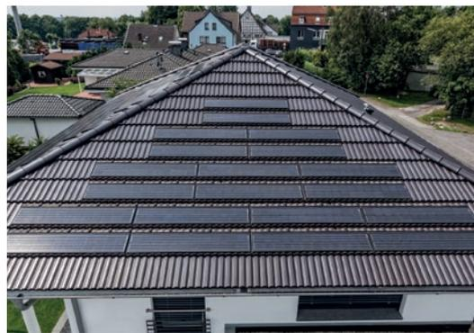
Abb. 6: Großflächenziegel MS5 mit 2Power
