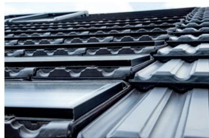
Abb. 10: Unten werden die Module gedübelt
