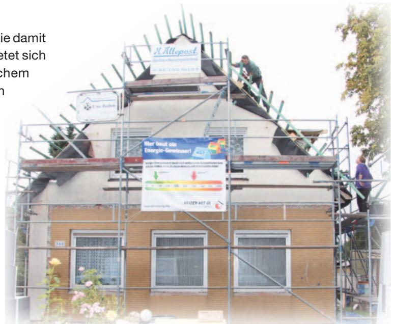
Abb. 1: Beim Energie-Gewinner in Oldenburg sank der jährliche Heizölbedarf von 6000 auf knapp 1000 Liter durch Heizungserneuerung (Öl-Brennwerttechnik) und verbesserten Wärmeschutz an der Gebäudehülle.
