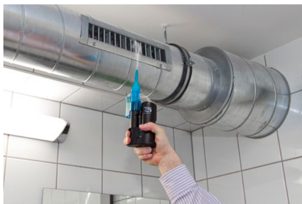
Abb.3: Einfach auszuführende Strömungsprüfung mittels Nebelpistole
