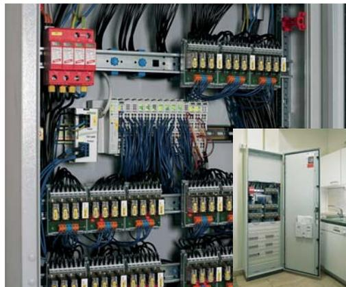
Abb.2 Das Herz der Steuerung: WAGO Feldbusknoten mit Ethernet Controller (Bildmitte) umgeben von schienenmontierbaren Relais-Bausteinen Platzsparer: Ein schmaler Schaltschrank in der Teeküche reicht als Etagenverteiler
