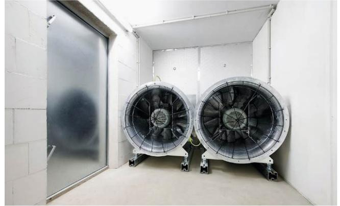
Drehzahlgesteuerte Ventilatoren stellen situationsabhängig zu den Türöffnungen im Sicherheitsstiegenraum den benötigten Überdruck her. Die redundante Ausführung ist zwingend, denn der Ausfall eines einzigen Ventilators würde zum Totalversagen der Anlage führen.
