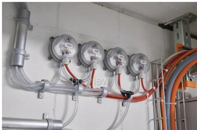
*Drucksensoren messen die Druckverhältnisse im Sicherheitstreppenraum, damit das gerade benötigte Luftvolumen exakt zugeführt wird. Hier ist die redundante Ausführung unverzichtbar.*
