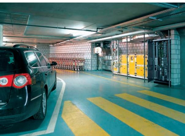
Abb.2 Konsequenterweise dezentral: Monoblocks (rechts im Bild) ersetzen die Technikzentrale.
