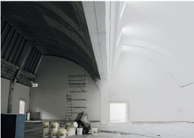
Abb. 3: Augsburger Garnspinnerei während Applikation Brandschutzbeschichtung
