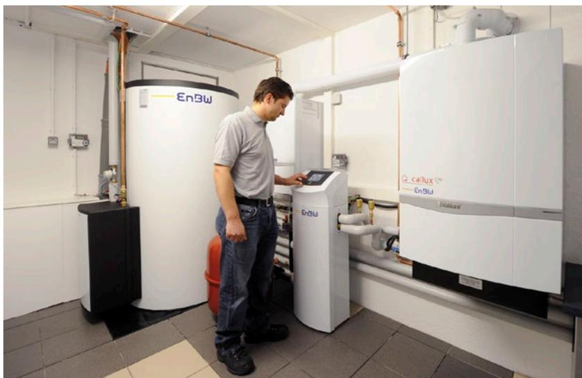
Abb.1: Wandhängendes Brennstoffzellen-Heizgerät von Vaillant, das im Rahmen des Praxistests Callux installiert wurde.
