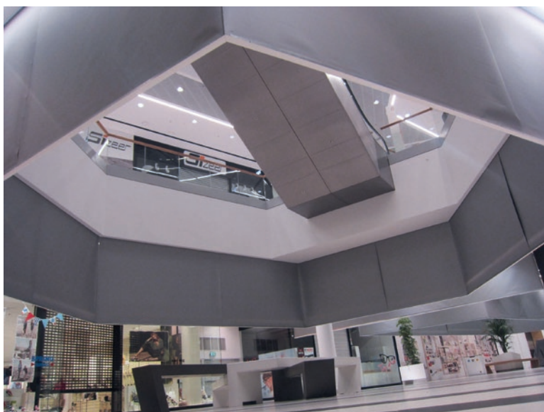
Abb. 3: SmokeMaster SM5, Einhausung eines Deckendurchbruchs im Shoppingcenter Echo Kielce in Polen
