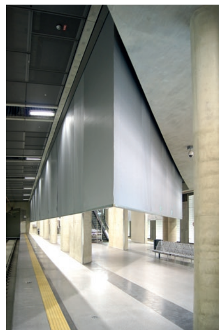
Abb. 4: SmokeMaster SM5 mit 30-Grad-Systemecke in der U-Bahnhaltestelle Heumarkt „neue Kathedrale von Köln“
