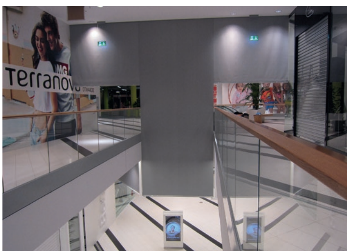
Abb. 12: SmokeMaster SM5, Rauchabschnittstrennung im Shoppingcenter Echo Kielce in Polen
