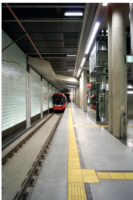
Abb. 6: SmokeMaster SM5 in den U-Bahnstationen der Kölner Verkehrsbetriebe
