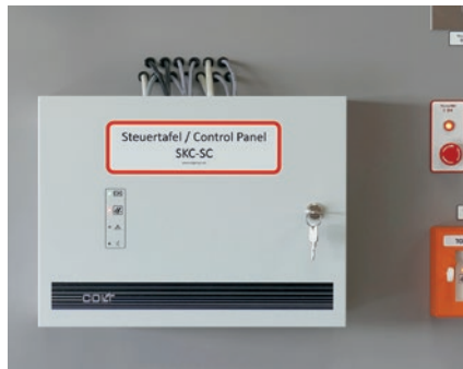
Abb. 10: Intelligente Steuerungstafel SKC-SC für Anlagen zur Rauchfreihaltung nach DIN EN 12101, Teil 9 und Teil 10
