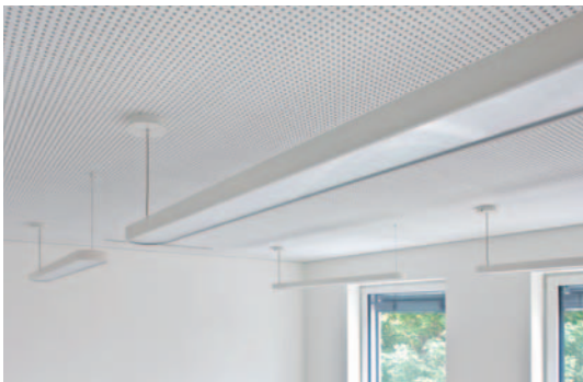
Abb.5: Bauobjekt Bürogebäude Wien
