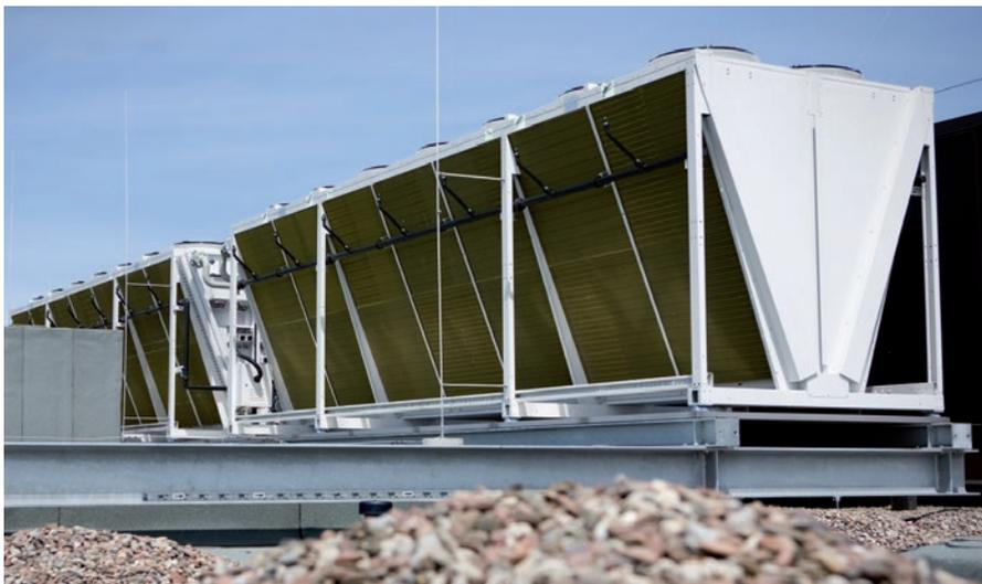
Abb.1: Doppelblock-Rückkühler vom Typ GFD mit angebautem HydroSpray-System
